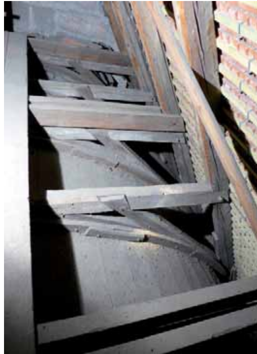
2: Tonnen- und Dachwerkkonstruktion etwa aus dem Jahr 1410.
