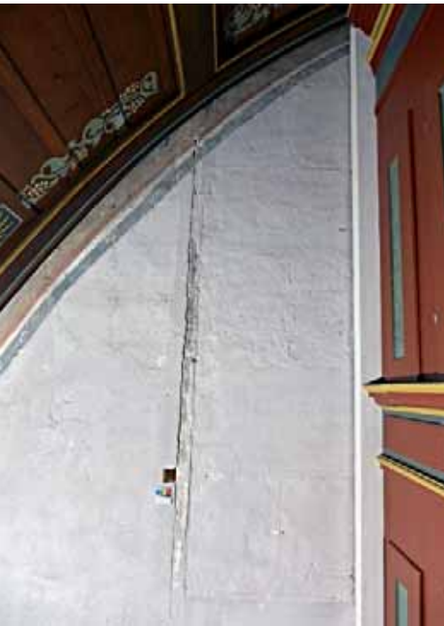
1: Deutlich zu sehen ist neben der Orgel die Außenkante des Turms; die sichtbaren Fugenbänder sprechen für eine ehemalige Außengestaltung.
