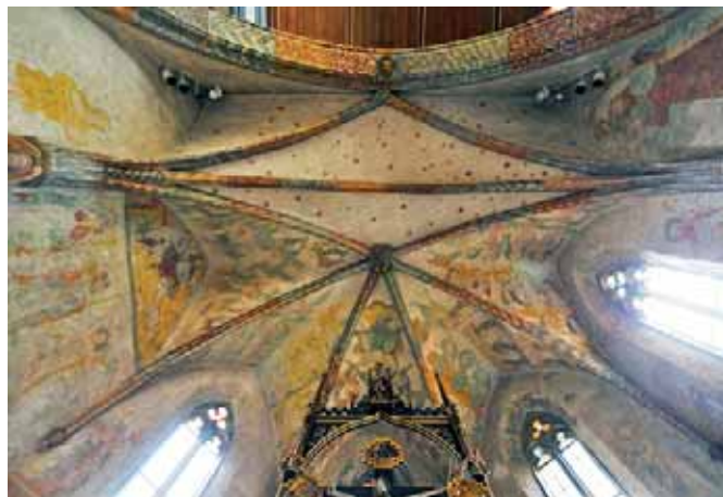
4: Blick ins Gewölbe des Chorraums mit Rippen.
